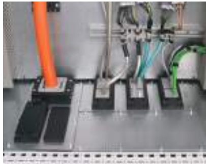
Kabeinführung mittels Modulplatten im Boden eines Rittal TS8 Schaltschranks. Montage mit icotek Bodenblech KDR-BMP.
