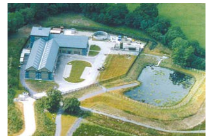
Beispiel für eine schwer erreichbare Pumpstation.
