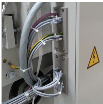
KEL-DPZ 24|x Seite 62 - 63 Einführung mehrerer Leitungen in ein Wandgehäuse nach Schutzart IP65. Für zukünftige Leitungen sind noch genügend Reserven vorhanden.
