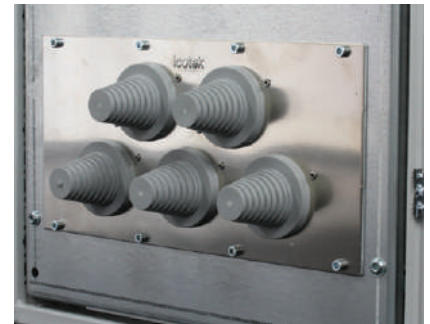
Kabeldurchführung mittels Modulplatten in der Trennwand eines Rittal TS8 Anreih-schranks.
