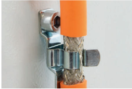
Direktmontage durch Verschrauben
